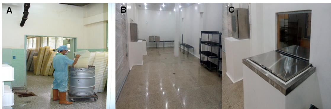
Figura 11. Área de acondicionamiento de equipos. A: Antes de la remodelación, ubicado en pasillo de circulación y paredes cubiertas con baldosa. Área de acondicionamiento de equipos. B-C: después de la remodelación, incorporación de tanque germicida y eliminación de baldosas, acabado de pintura epóxica
