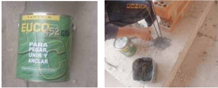
Figura 6. Epóxico Euco 452 Gel y anclaje químico de barras Fuente: los autores
