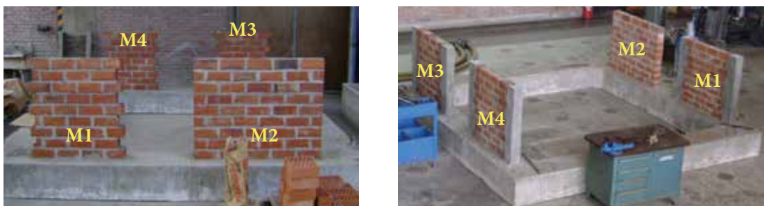
Figura 2. Parapetos analizados. Primero se construyó la albañilería sobre un anillo de concreto armado
