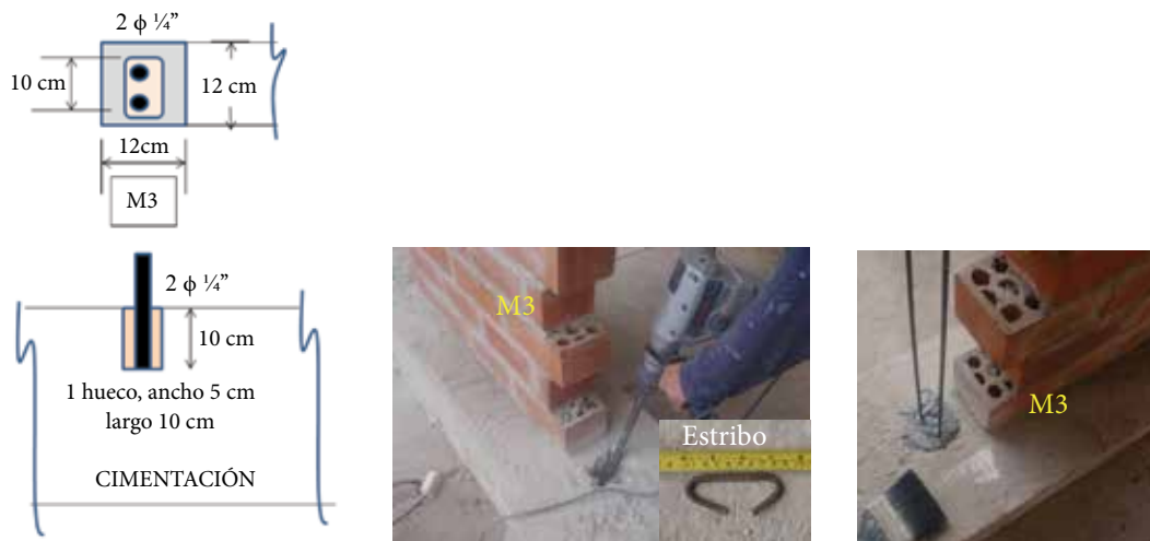
Figura 4. Refuerzo y anclaje en columnas del parapeto M3
