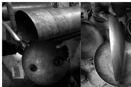
Figura 6. Fabricación del tanque Fuente: elaboración propia
