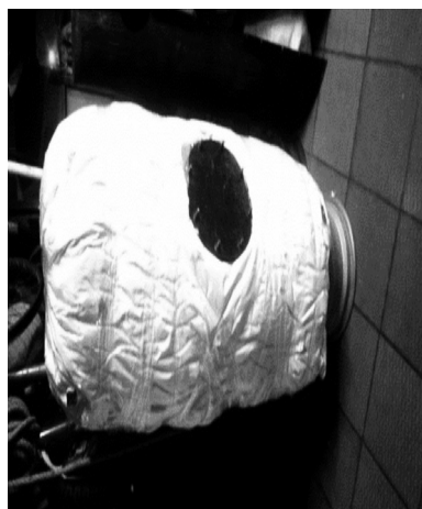
Figura 8. Montaje aislante (lana de vidrio) Fuente: elaboración propia
